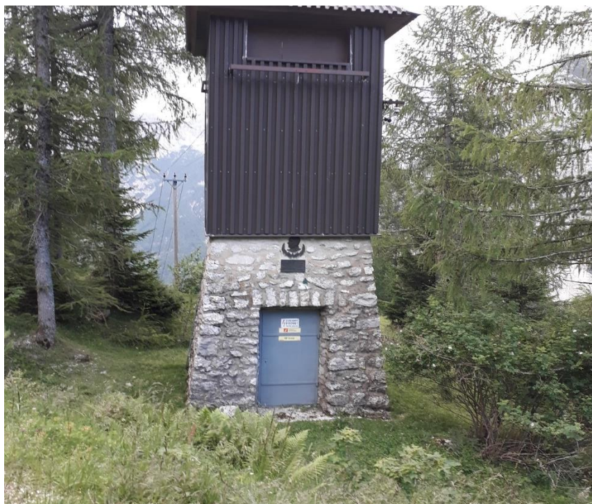
Slika 6: Transformator pod Erjavčevo kočo
