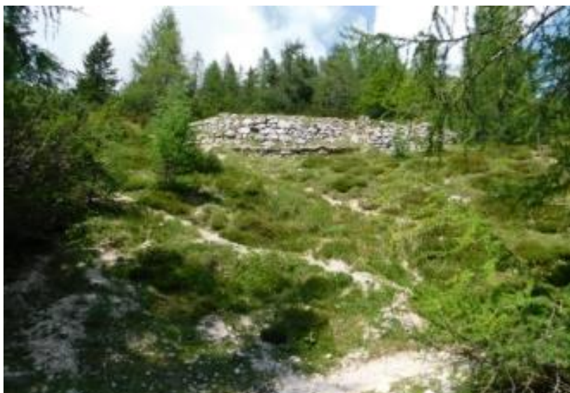
Slika 11: Bližnjice ki uničujejo zimsko cesto nad Erjavčevo koč
